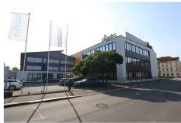
Nord-West-Ansicht des Bewertungsobjekts
