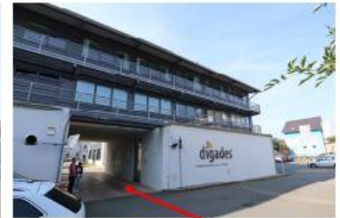
Ost-Ansicht des „Haus 2“ mit Durchfahrt im Erdgeschoss
