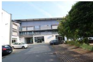
Teil der Süd-Ansicht des „Haus 2“
