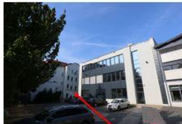
Nord-Ost-Ansicht des „EZ“ und „Haus 1“
